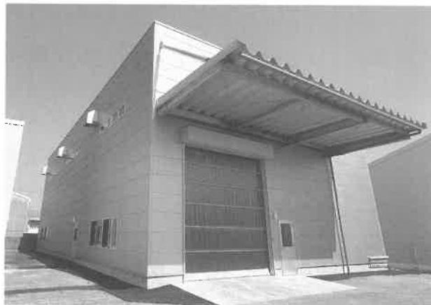
4月から稼働する第3工場
